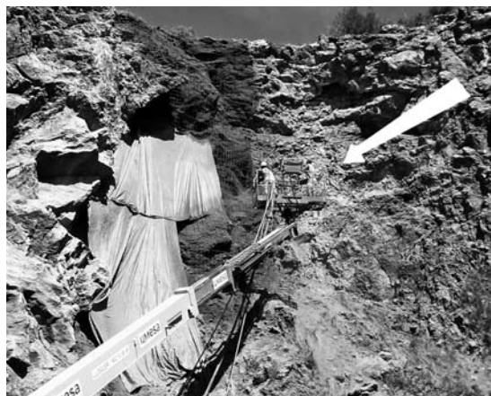
Projecció de gunita a la paret, per tal de subjectar la malla metàl·lica electrosoldada i els volums rocosos inestables.
